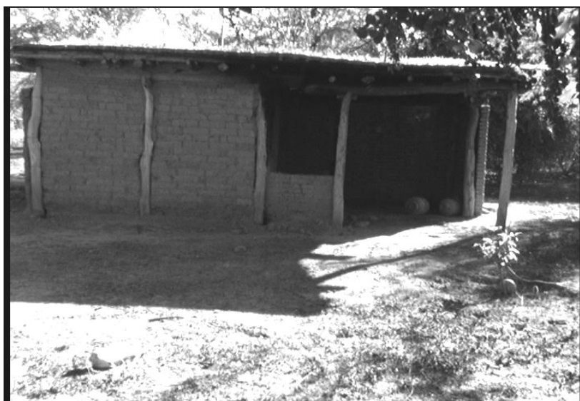
Primera vivienda – rancho – que habitó Severiano. Foto: Julio Laurino
