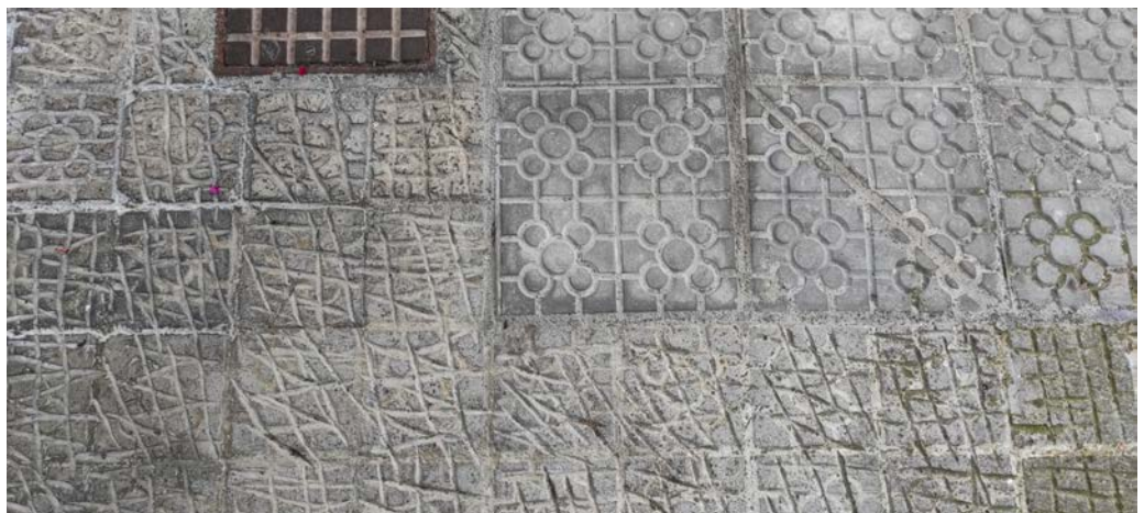
Ibilbide maldatsuetan zoladura irrisgaitzak lehenetsi behar dira, espero ez den zoladurek ere arazoak eman bait ditzakete (Bermeoko adibide honetan hormigoizko baldosa marratu behar izan dute irristaketak eta erorketak direla-eta).
