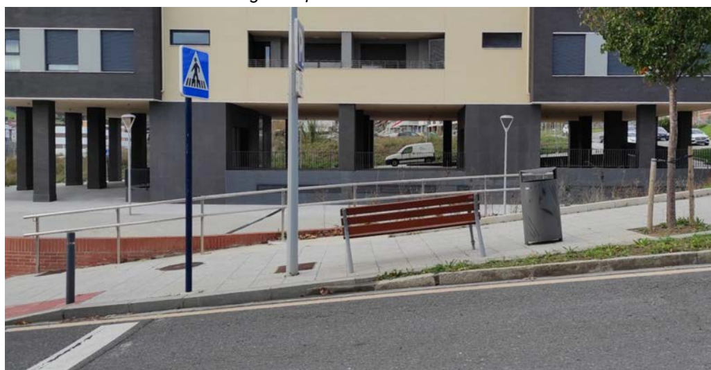
Bermeoko eserleku hau jartzerakoan ez da kontuan hartu ibilbidearen malda: eserlekuaren erabilgarritasuna eta erosotasuna zailtzen du honek.
