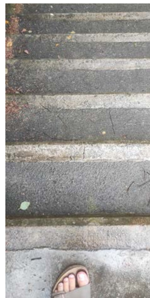
Kromatikoki desberdidutako mailek segurtasun baldintzak areagotzen dituzte.
