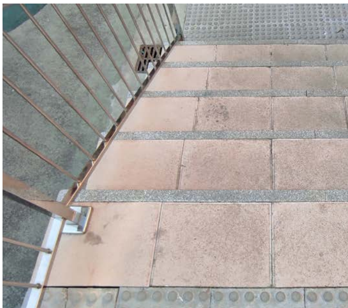
Kromatikoki desberdidutako mailek segurtasun baldintzak areagotzen dituzte.
