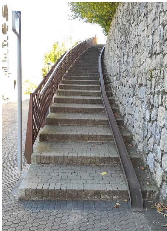
Bizikleten erabilera aurreikusten den inguruneetako eskaileretan errai bat kokatzea gomendatzen da, arrapalarik ez badago.
