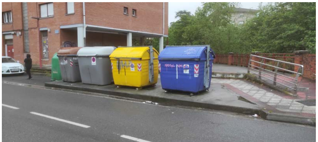
Bedarretan plataforma eraiki zen edukiontziak irisgarriagoak izateko. Ikus plataforma prefabrikatuak, "2.1.b Autobus-geralekuak egokitu" fitxan.
