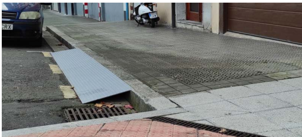
Ibiak eraikitzeak, aldiz, arazoak eman ohi ditu. Irudietan koskarik gabeko ibiak bermatzeko hainbat irtenbide: Bermeo, Legorreta, Bermeo.
