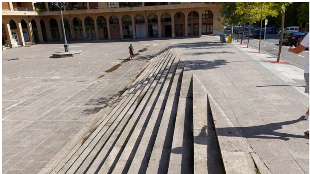
Oso ohikoa da eskailerak aldapen kontra errematatzeko modu hau. Irisgarritasunaren eta segurtasunaren ikuspegitik ez da irtenbide ona.
