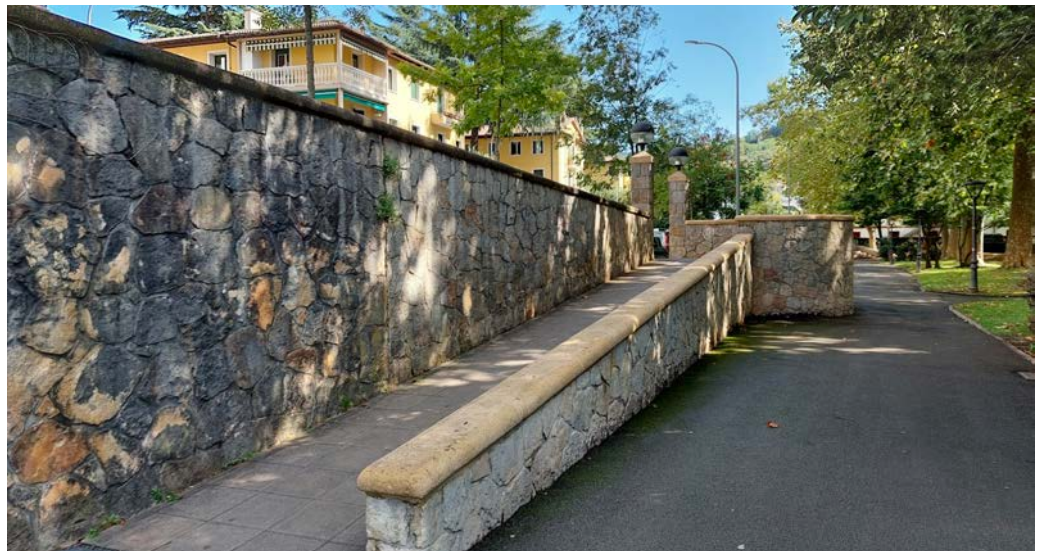
Arrapalek atsedean hartzeko eskailera-buruak izan behar dituzte, eta zenbat eta malda handiagoa izan, orduan eta laburragoak izango dira hauen arteko tarteak. Asko dira tarte horizontalik gabeko arrapalak, Ordiziako hau, esaterako.
