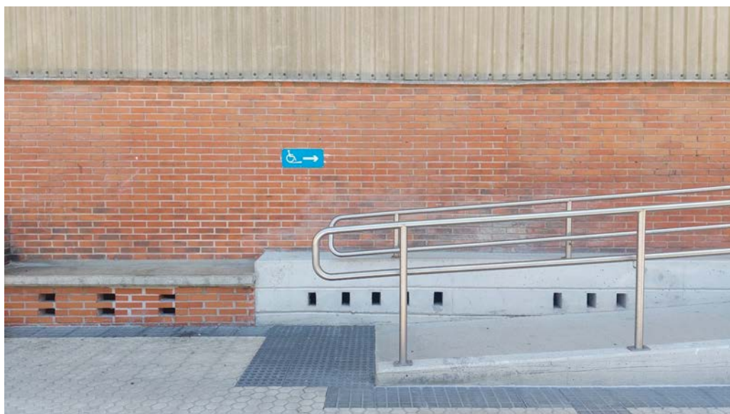
Andoaingo Arrate Pilotalekuko arrapala eta seinaleztapena. Araudiak ezartzen dituen eskakizunak betetzen ditu.
