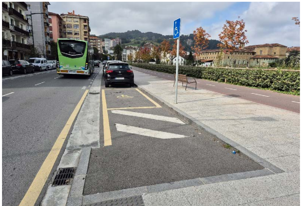
Goiko bi irudietan: Aparkaleku egokitua ilaran: transferentzia-eremua zebra-bide aldera jarri da, ibia bertan eraiki delarik, asfaltozko arrapala baten bitartez. Zarautz.
